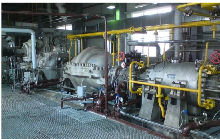
Рисунок 11 - Компрессорный агрегат 1984г. выпуска ТК-102 после капитального ремонта, монтажа и ввода в эксплуатацию в 2010г
