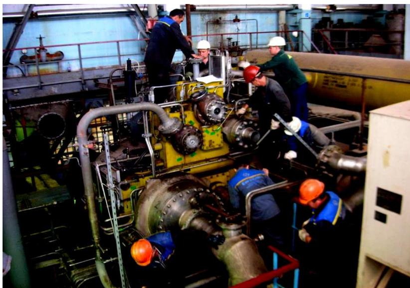
Рисунок 12 - Многовальный 10-ти ступенчатый электроприводной компрессор GK-530/10 фирмы MANN-BORSIG
